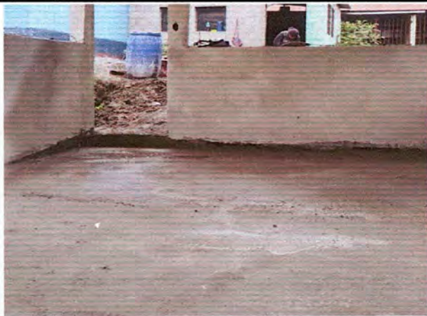
Foto 3: Proceso de mejoramiento de losa de piso.
