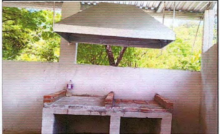
Foto 4: Proceso de instalación de polleton.
